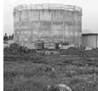
Uno dei vasconi di depurazione (M.M.)
